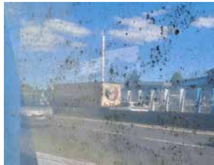
Photo de pollution sur les murs antibruit de la rocade : les particules fines sont la cible de Santé Publique France.
